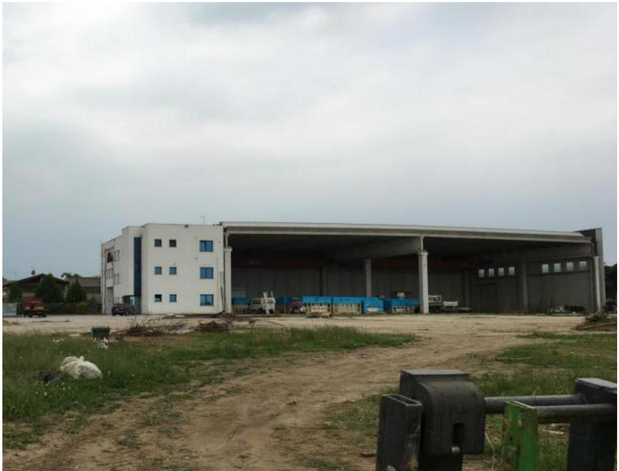
L'area di pertinenza risulta parzialmente pavimentata in asfalto nella zona dei cancelli carrai per l'ingresso ed uscita automezzi, e pavimentata in ghiaio costipato per quanto riguarda le aree di stoccaggio materiale, le aree di deposito e le zone di sosta degli autoveicoli.
